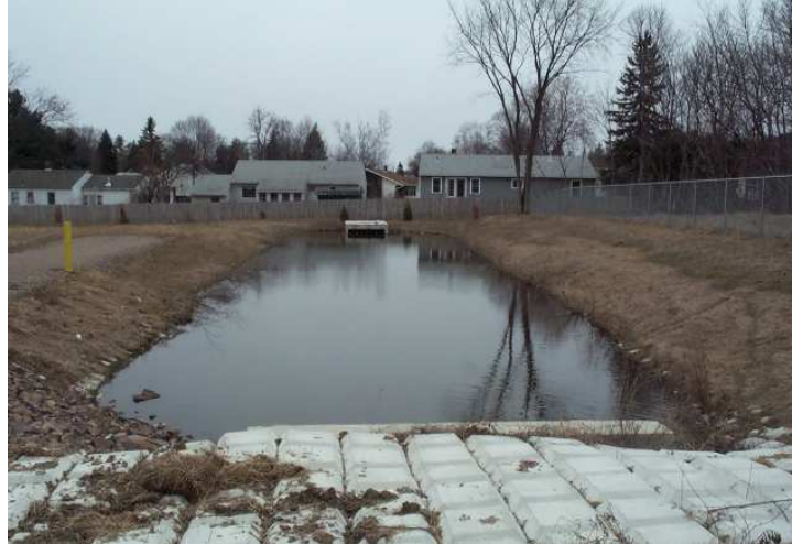
O8 Pond Forebay
